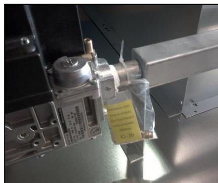
1. Die Injektoren an der Seite des Brennkastens ausfindig machen. Den Injektor so weit herausschrauben, bis er mit Hilfe des Schraubenschlüssel (SW 13) entnommen werden kann.
